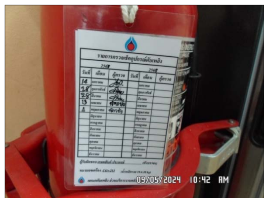
รูปที่ 26 ตัวอย่างการตรวจสอบและบำรุงรักษาอุปกรณ์ป้องกันและระงับอัคคีภัย
