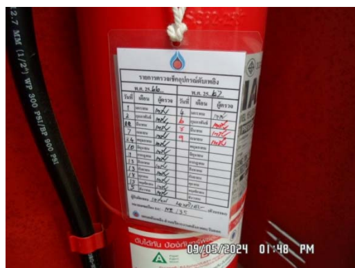
รูปที่ 25 ตัวอย่างการตรวจสอบและบำรุงรักษาอุปกรณ์ป้องกันและระงับอัคคีภัย
