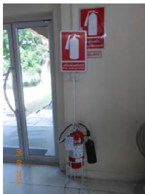
รูปที่ 34 ถังดับเพลิงแบบมือถือบริเวณจุดต่างๆ ของโครงการ
