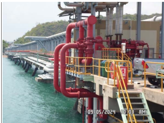
รูปที่ 32 ปิมน้ำดับเพลิงและรถดับเพลิงฉุกเฉิน
