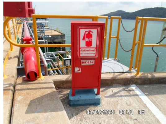
รูปที่ 34 ถังดับเพลิงแบบมือถือบริเวณจุดต่างๆ ของโครงการฯ (ต่อ)
