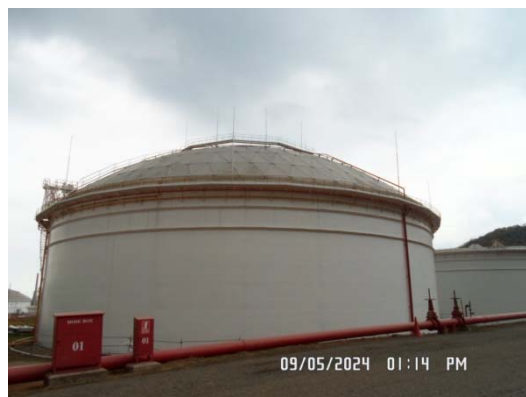
รูปที่ 1 ถังเก็บสำรองน้ำมันออกแบบให้มีความสูง 2 ชั้น เพื่อลดการปล่อยไอสารอินทรีย์ (VOCs)
