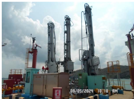
รูปที่ 1 ระบบ Vapor Return บริเวณท่าเทียบเรือ
