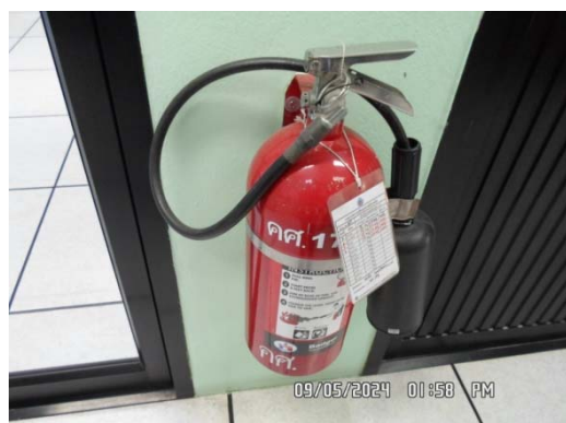
รูปที่ 25 ตัวอย่างการตรวจสอบและบำรุงรักษาอุปกรณ์ป้องกันและระงับอัคคีภัย
