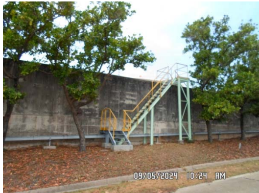
รูปที่ 3 ผนังกัน (Concrete Bund) ระบบถังเก็บสำรองน้ำมัน
